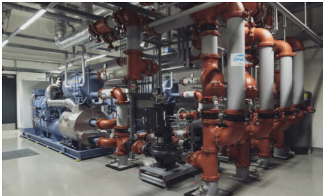
STACKIT kühlt sein Colocation-RZ mit zwei 1,8-MW-Ammoniak-Kältemaschinen (Abb. 4).
