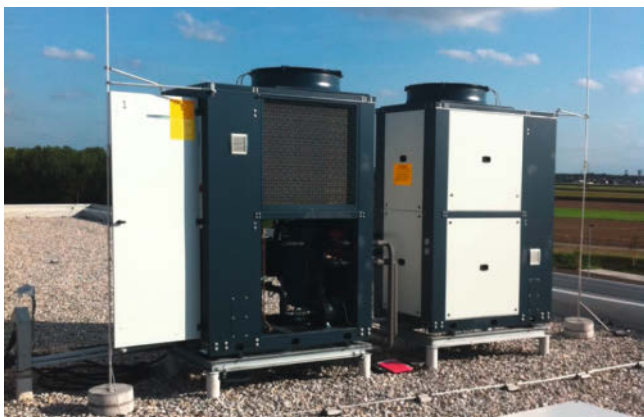
Diese zwei R290-Flüssigkeitskühler sind in Außenaufstellung mit jeweils 12 kW Nennkälteleistung installiert (Abb. 5).
