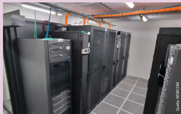
Racks und Kühler bilden eine Reihe. Passend zu den Kühlern wurden Racks mit 120 cm Tiefe und 48 HE gewählt (Abb. 1).
